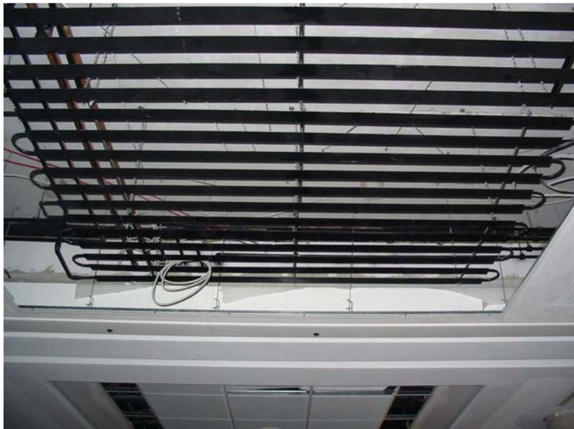
Im Hintergrund des Fotos (Bildunterseite) sehen Sie die eingelegten Streckmetallkassetten. Die Kühldecke kann nach seiner Aktivierung seine Leistung entfalten und bleibt für die Augen der Betrachter nach eingelegter Streckmetall-Decke unsichtbar.
