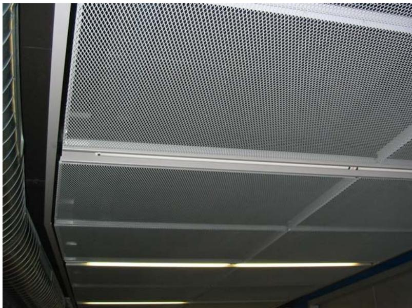
Die Streckmetallkassetten können durch das offene Fugensystem auch optisch hochwertig in trapezform, polygonal und anderen nicht-winkligen Formen hergestellt und montiert werden. Durch das einprägen der Positionsnummern in den Stirnseiten (auf Wunsch) kann auch das Sortieren bei großer Stückzahl verschiedener Plattentypen ein reibungsloser Montageablauf gewährleistet werden. Der Randabschluss erfolgt durch ein einfaches Einhängeprofil, wie beim System VES-L110.
